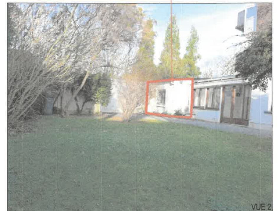
A2- VUES DES DEMOLITIONS
